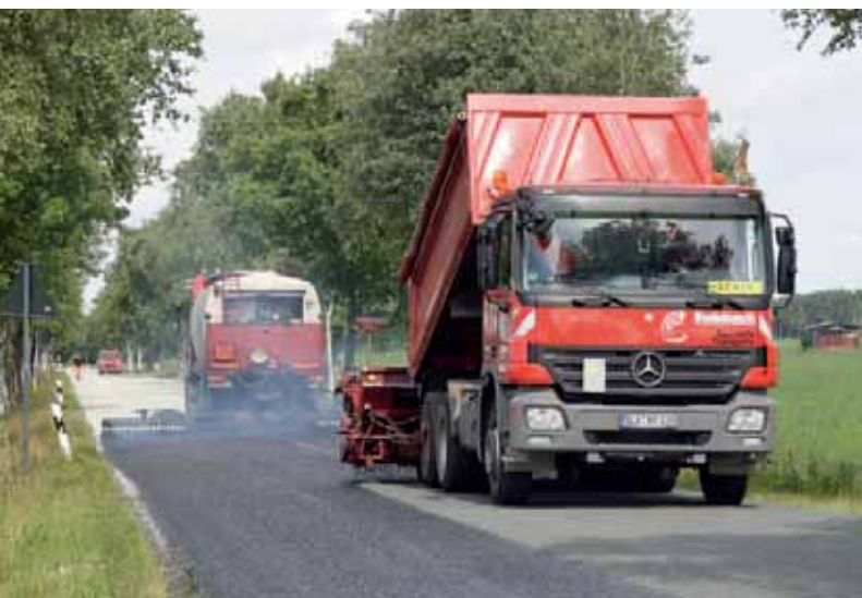
Zweiter Absplittvorgang fr Trnkdecke.
