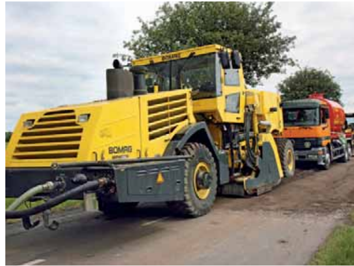
Herstellung der KRC-Schicht mit anschließender Nivellierung.
