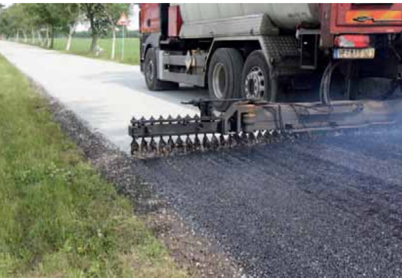
Aufspritzen von Heibitumen fr Trnkdecke.
