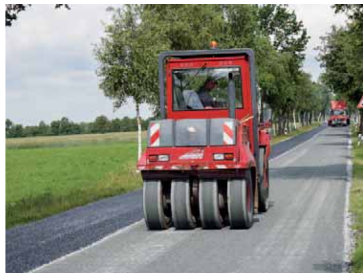
Abwalzen der zweiten Splittschicht mit einer BW 151 AC-2.
