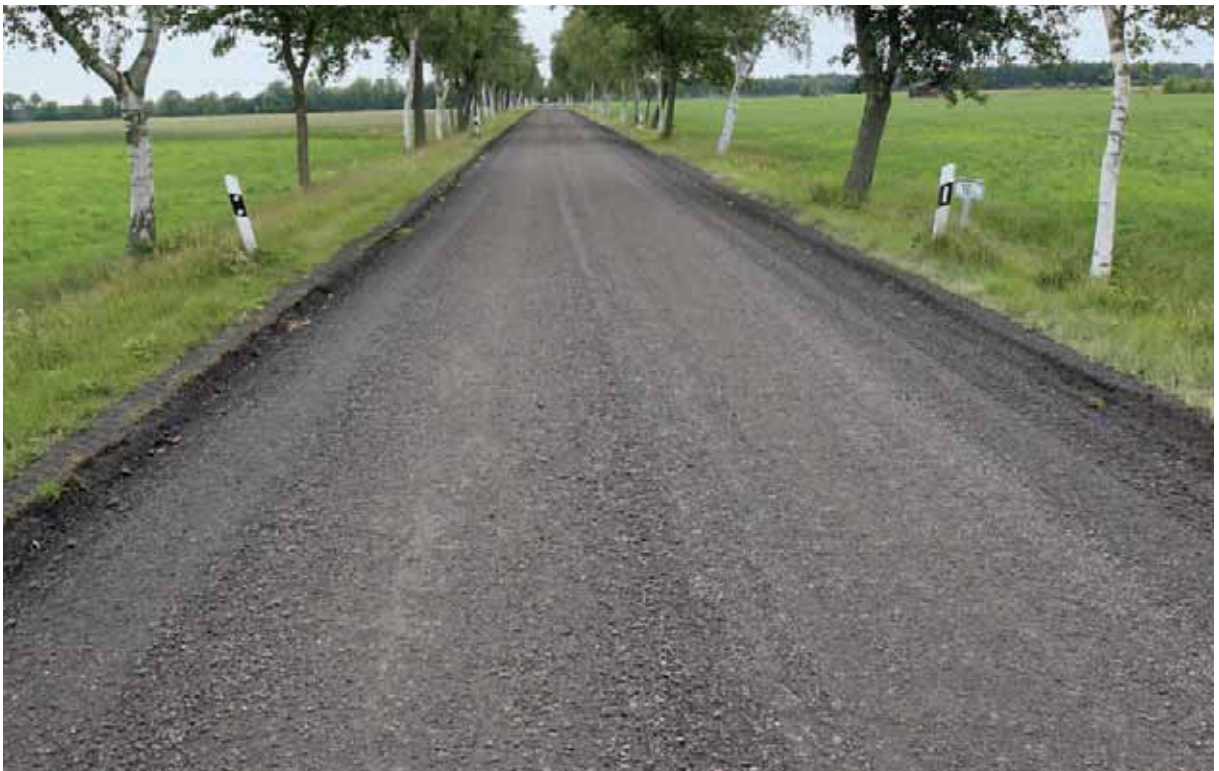
Fertiggestellte Kaltrecyclingschicht.
