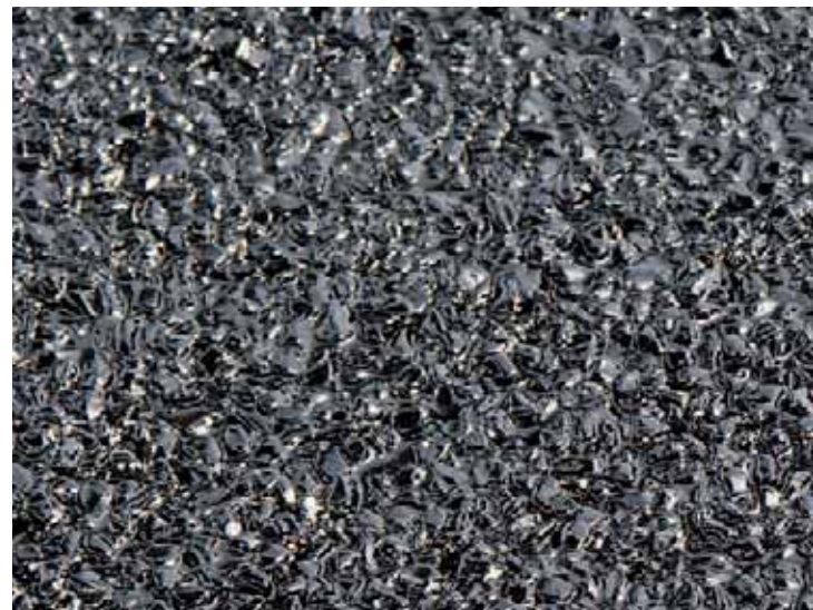
Erste Lage Trnkdecke vor Auftrag zweite Lage Splitt.
