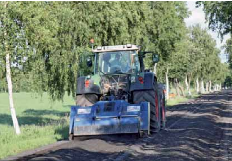
Zerkleinerung von großen Steinen in der oberen Lage.
