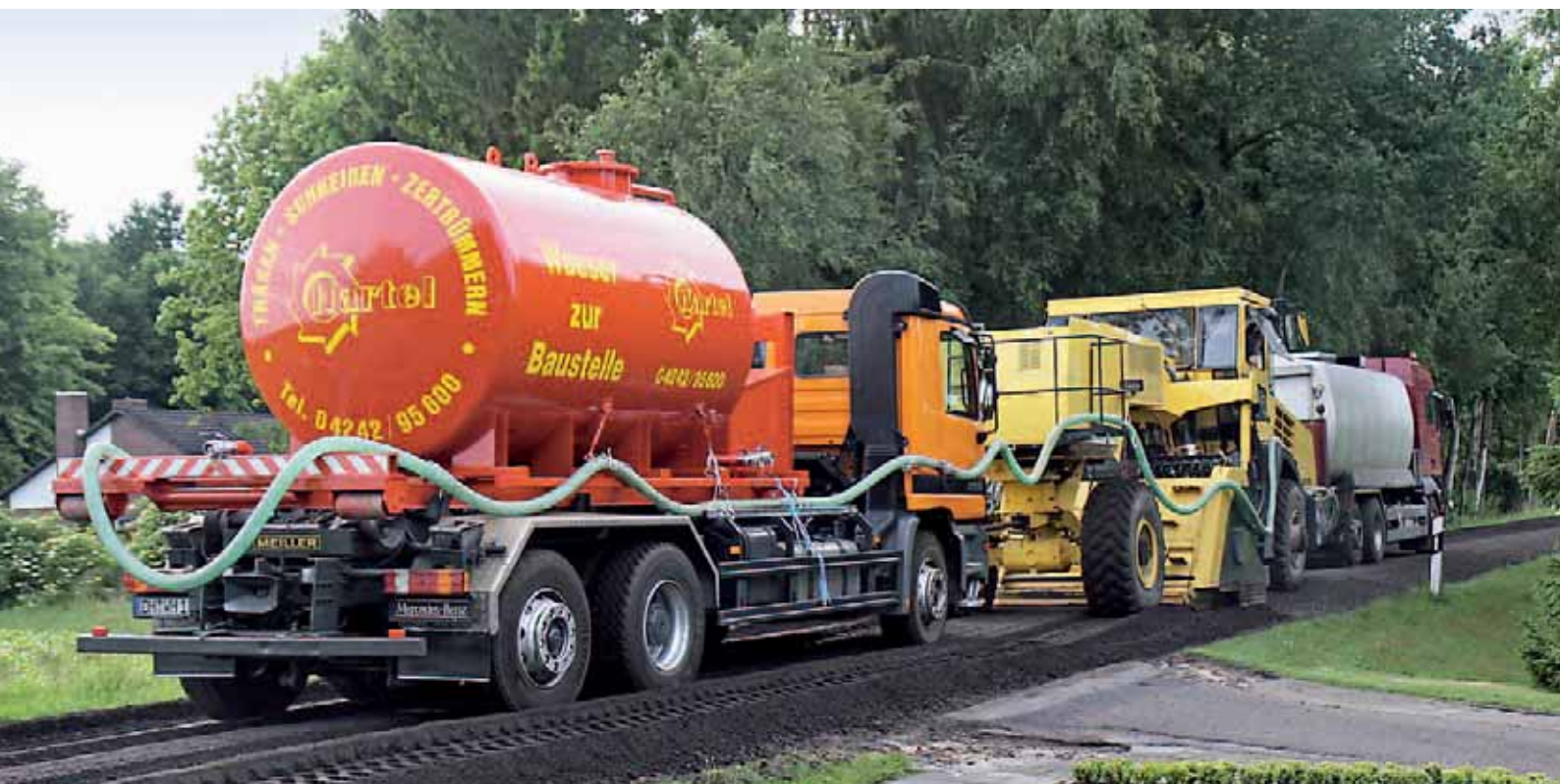
BOMAG Fräsrecycler MPH 125 beim Einmischen von Schaumbitumen und Mischwasser.
