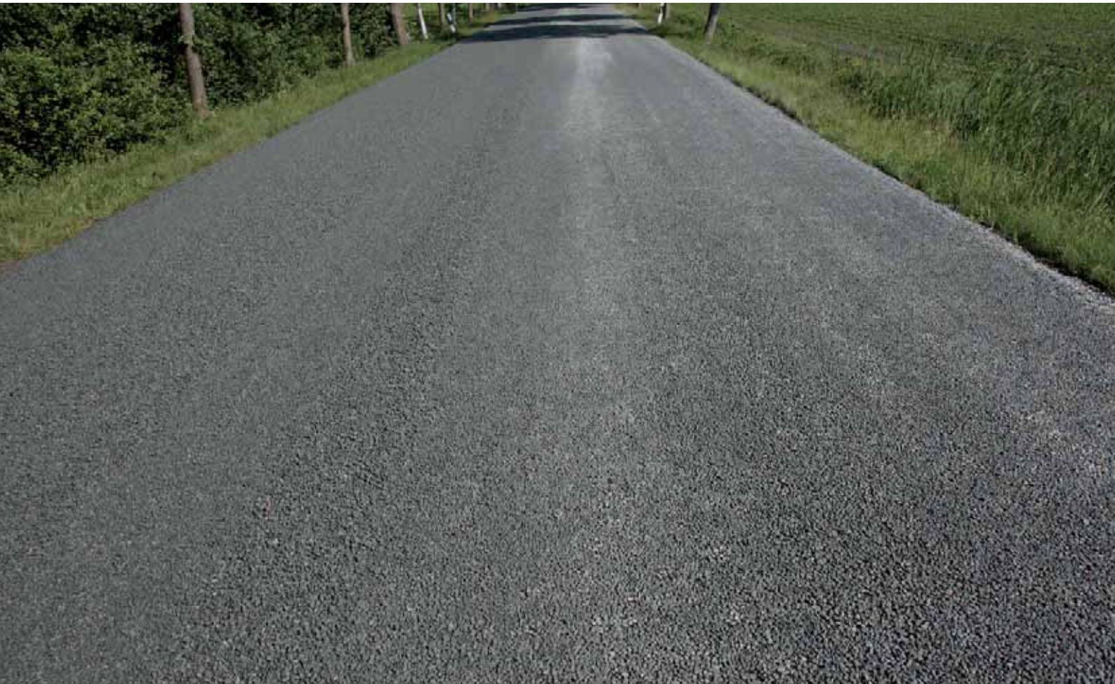
Mit Tränkdecke fertiggestellte K 101.
